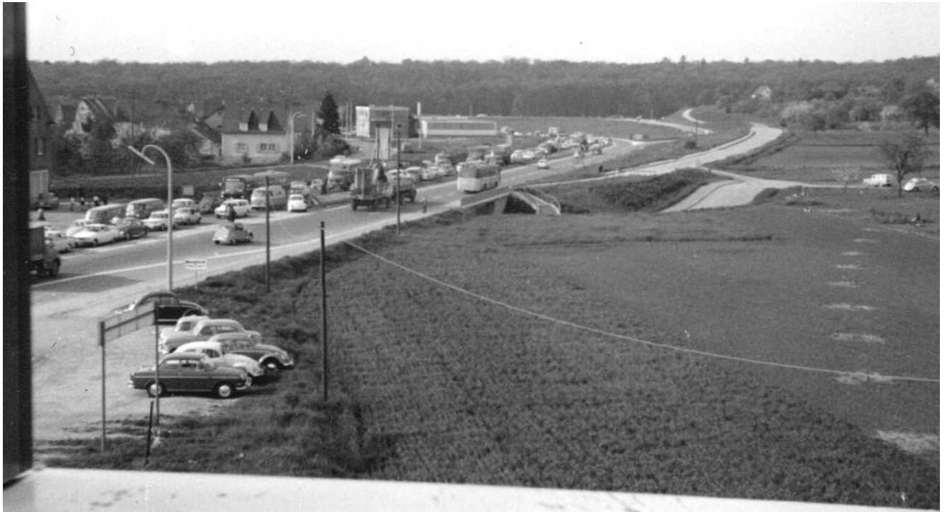
Blick von Ulmer Straße 7, 4. Stock auf die B 27 beim Bau im Jahr 1964
