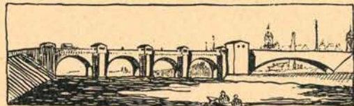
Neckarsulm: Brücke über den Neckar
