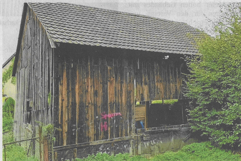
Scheune mit Loch: Der Neckarsulmer Dirk Bönisch hat gerade noch rechtzeitig vor dem Abriss das Holzstück mit der Schrift rausgesägt.
