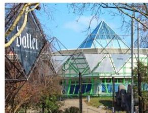
Auf die Neckarsulmer Ballei ist Erhard Klotz besonders stolz, denn die gute Vorbereitung sicherte später einen schnellen Bau.
