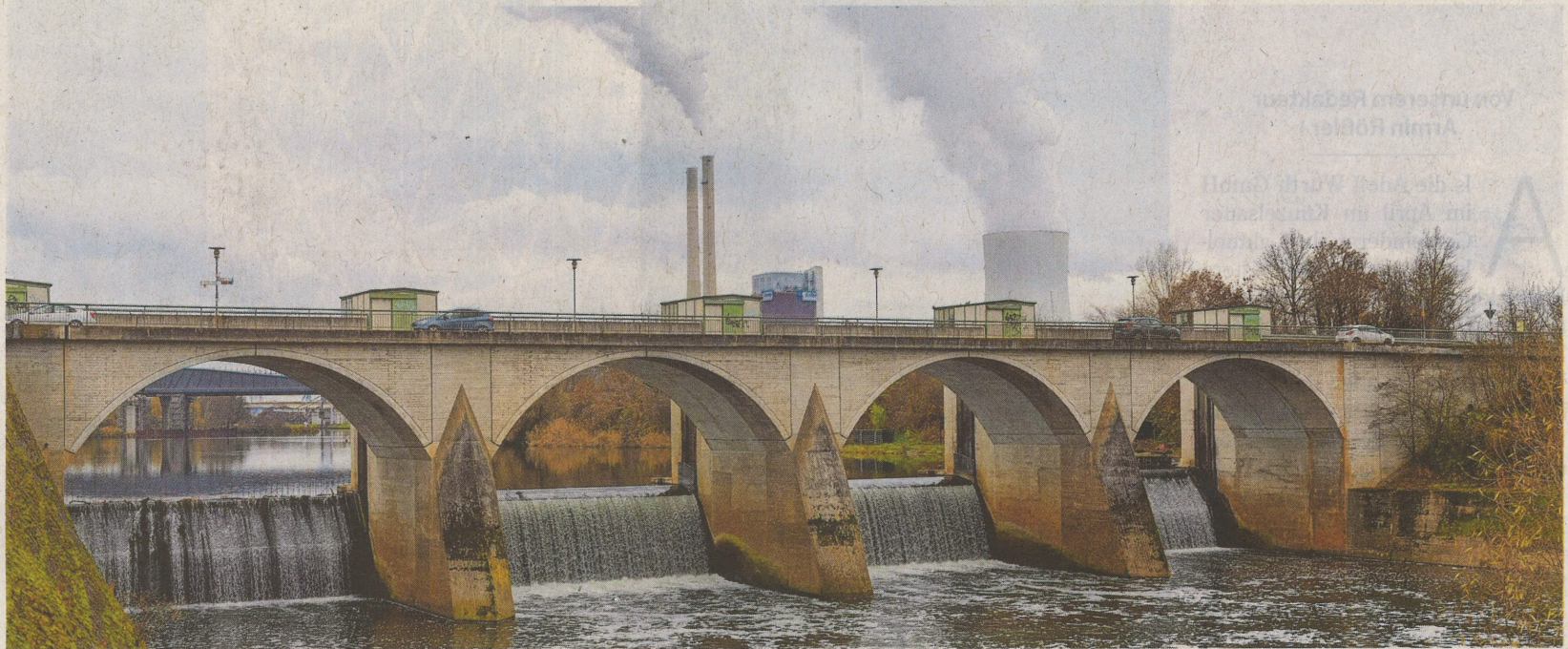
Wird in ein paar Jahren so nicht mehr stehen: Die Brücke wird ersetzt, das darunterliegende Wehr bekommt ebenfalls einen neuen Standort.
